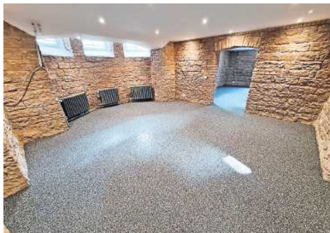
Bema Bauchemie bietet einen Bodenbelag aus einem Guss, ohne Fugen: den sogenannten Steinteppich.
