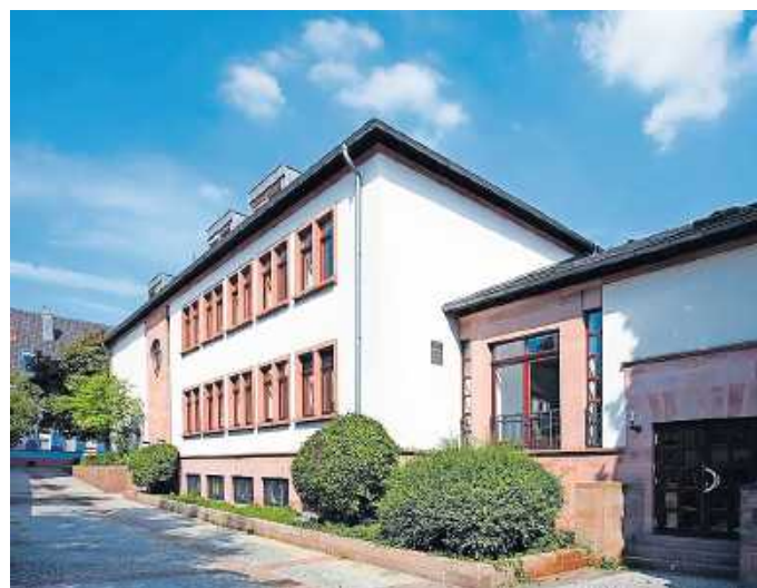
Das Gebäude der VHS in Kaiserslautern.
