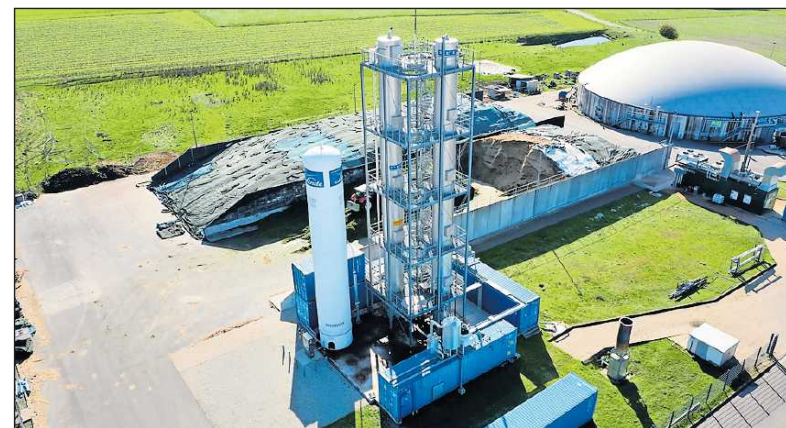
Der Energiepark samt Biogasanlage in Winzeln.
